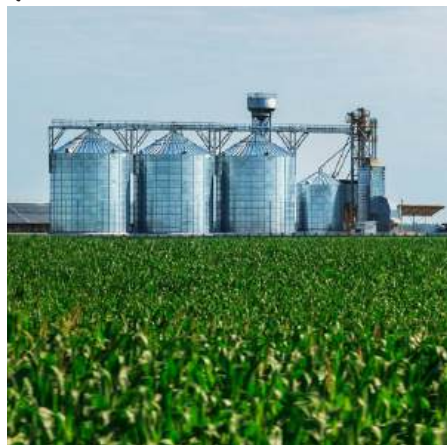
Bin Fan Monitor
